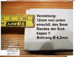
Verbohrung (Befestigung) von vorne (sichtbar)
