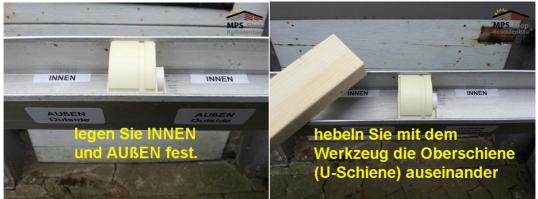
Es gibt eine Vielzahl von Herstellern und Bandspulen - aber das Prinzip ist (fast) überall gleich... Setzen Sie nun das Werkzeug (ggf. 2 - beidseitig) neben der Bandspule an und spreizen Sie das U-Profil der Kopfschiene
