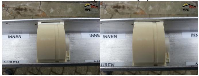
nun die U-Schiene wieder zusammendrücken bis die U-Schienen-Bördelung wieder richtig auf den "Nasen" der Spule sitzt - fertig, das erste Band ist gewechselt und wird nun von oben nach unten durch die einzelnen Lamellen gefädelt - OHNE ES unterwegs ZU VERDREHEN !!!
