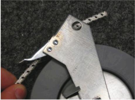
Eine Nahaufnahme zeigt die weiße, geflochtene Schnur, die durch einen Metallklemmer an der Innenseite des Rolladenpanzers geführt wird.                                                                | <p>Die Schnur durch den Klemmer am Gestell fädeln.</p>                                                                                              |
